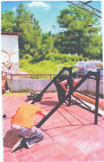
Aufbau des Grundgestells für die Warmwasser- anlage durch die Projektteilnehmer
